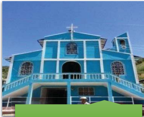
Iglesia de San Antonio ubicada en la cabecera parroquial
